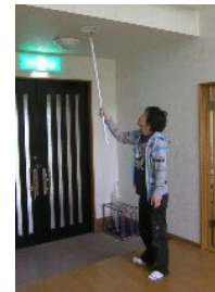
非常用照明を検査
